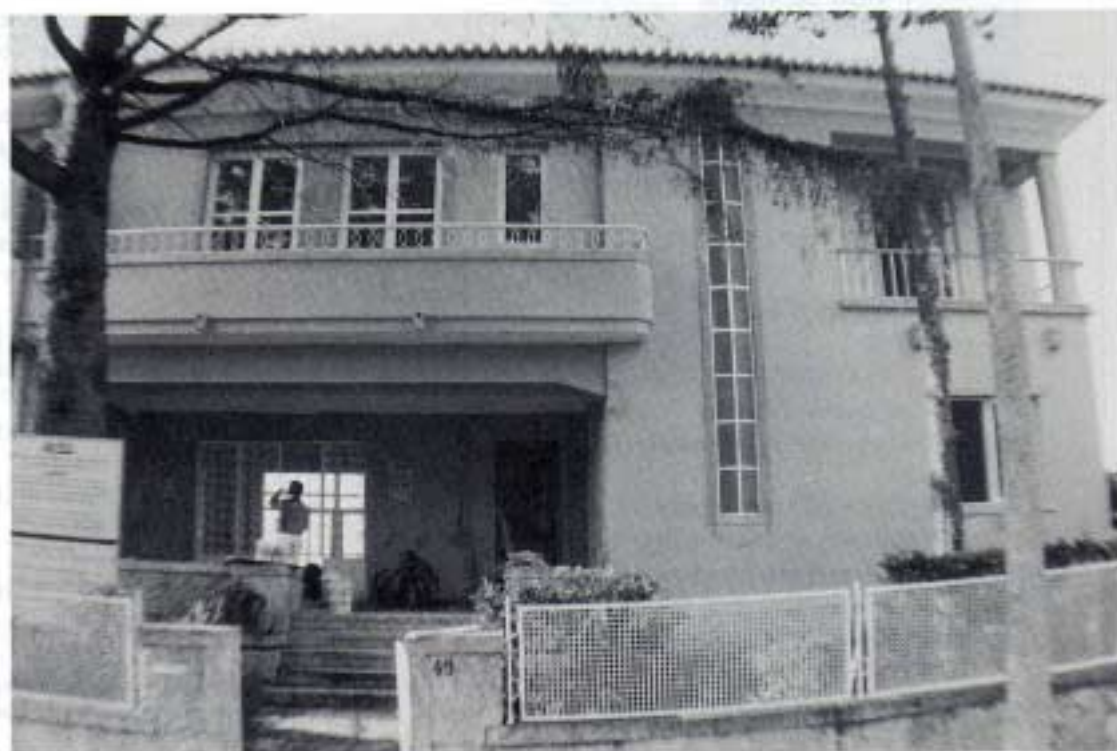
Vista da fachada posterior que dá para o jardim
