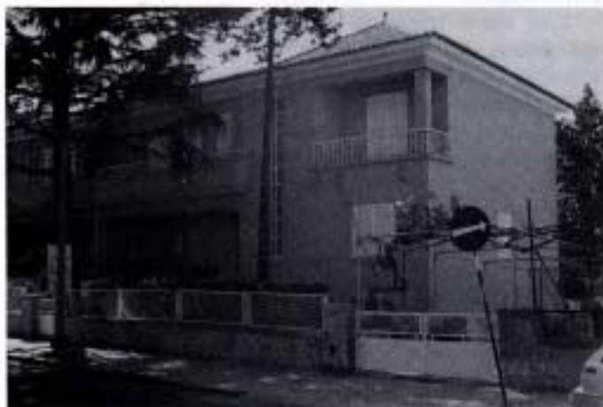
Fachada principal da Sede do Instituto D. João de Castro
